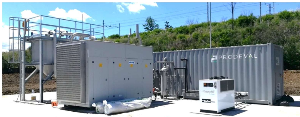
Figura 15: impianto di "upgrading" – esempio d'installazione
